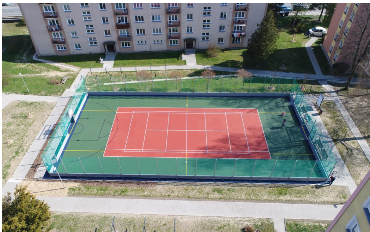
Víceúčelové hřiště pro veřejnost Vsetín-Luh
